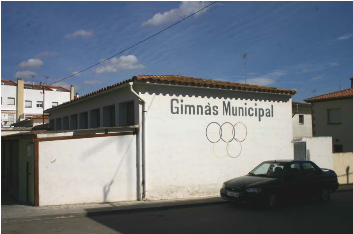
Foto nº45. Instal·lacions del Gimnàs Municipal
