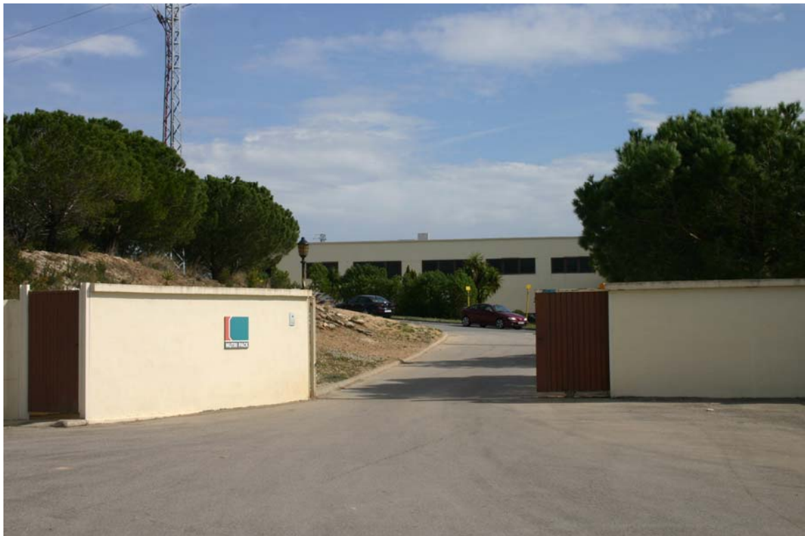
Foto nº34. Instal·lacions de Nutripack al municipi de Banyeres del Penedès.
