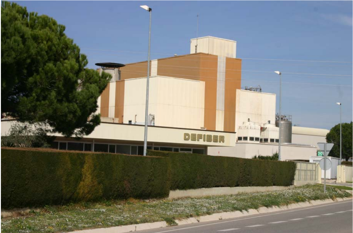
Foto nº33. Instal·lacions de DEFIBER al municipi de Banyeres del Penedès.
