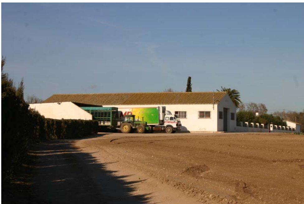
Foto n°36. Instal·lacions de Fruit Camp al municipi de Banyeres del Penedès
